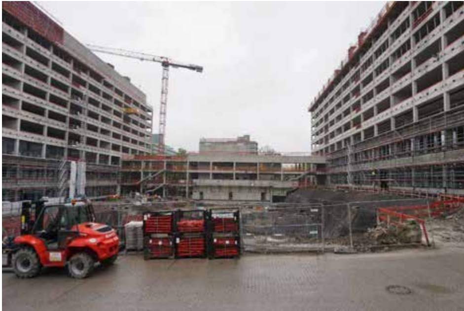
Bild 4.42: Die Rohbauten der wiederaufgebauten Gebäude IA und IB sind im Oktober 2016 bereits weit fortgeschritten. Zwischen diese beiden Gebäude kommt das neue Forschungszentrum ZGH.
