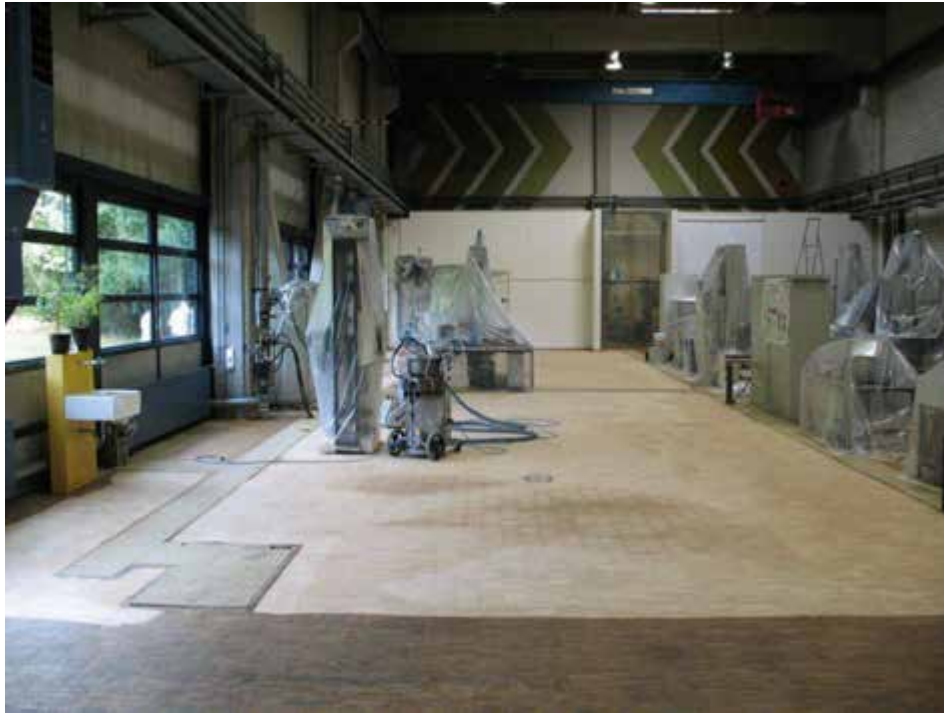
Bild 4.6: Versuchshalle des Instituts für Werkstoffe während der Renovierung, 2012.
